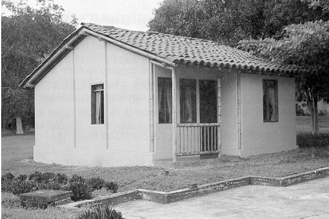
Construcción de casas de interés social con bambú. (Tomada de Cruz, 1994)
