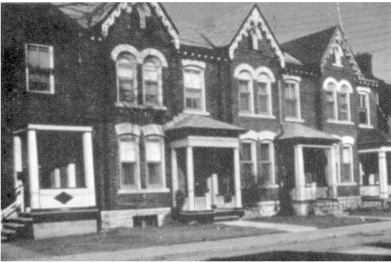
Casa habitación con estructura de madera de casi 100 años de antigüedad recubierta con materiales pétreos
